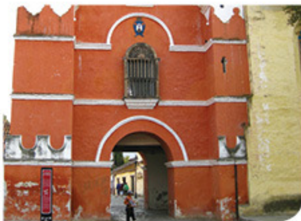
3.67. El arco/torre de El Camón en San Cristóbal de las Casas es un ejemplo de arquitectura mudéjar que recuerda a construcciones similares en Andalucía (España).
